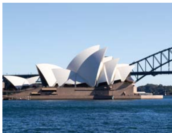
Nejllepší produkty na světě pro nejlepší architekturu na světě: architektonická ikona Sydney Opera House od Jørna Utzona.
